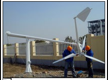
Fig 8(d) Tiltup tower
